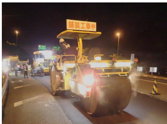
<舗装補修工事>
