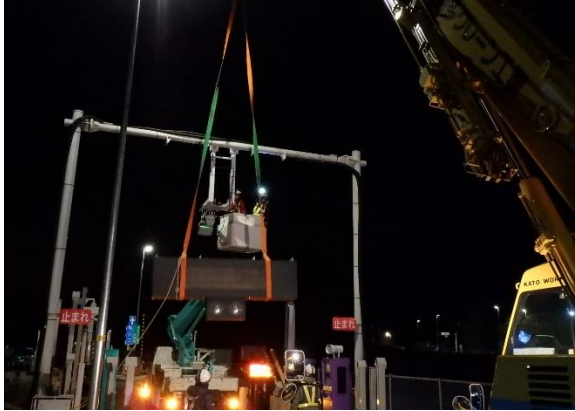
<ETC 設備更新 作業状況>
