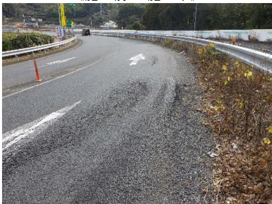
《施工前 or 施工中》
