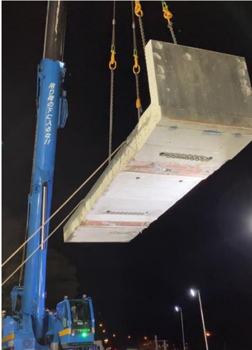
《既設床版撤去状況》
