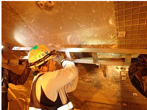
《構造物補修状況》
