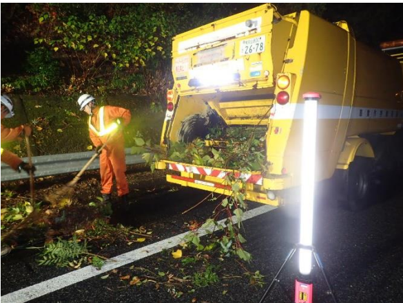
《樹木伐採作業状況》
