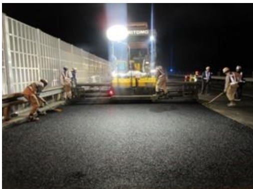
《舗装補修工事》
