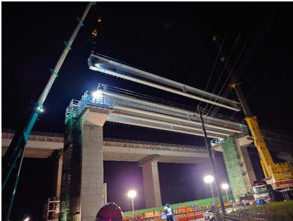
＜架設工(PC 上部工)＞
