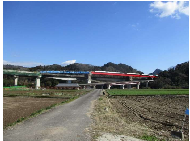
＜架設工(鋼上部工)＞
