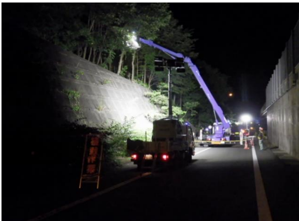
《伐採状況写真》
