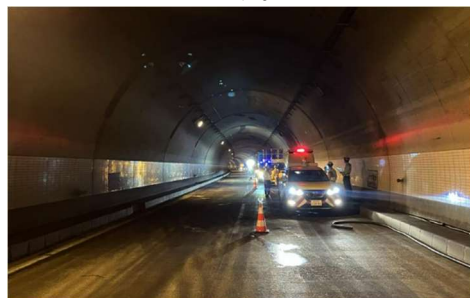
(追越車線側トンネル照明等設備復旧状況)
