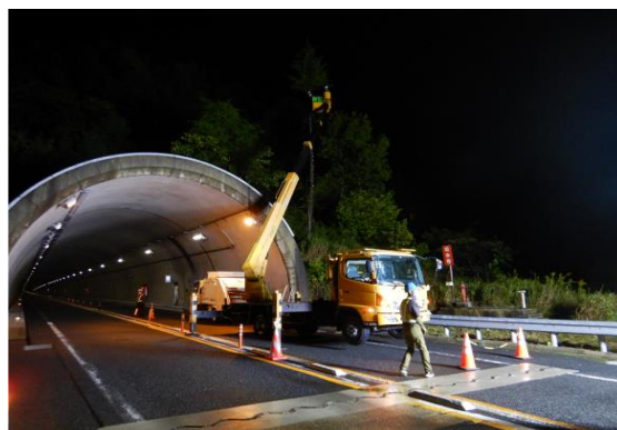
樹木伐採作業
