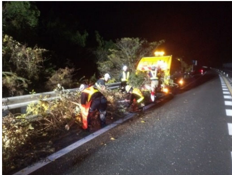
植栽作業(樹木伐採)
