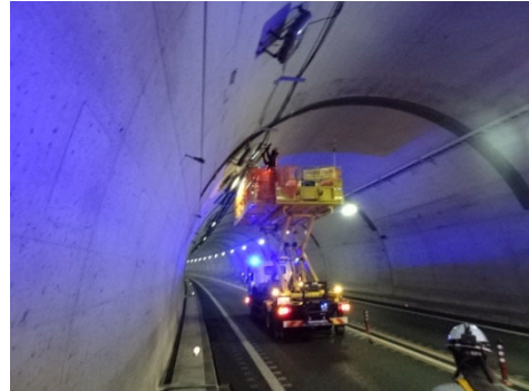
トンネル設備更新
