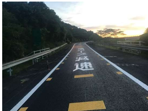
<舗装補修工事> 施工後
