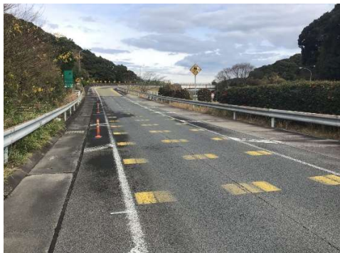
<舗装補修工事> 施工前
