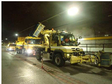
<トンネル側壁清掃>
