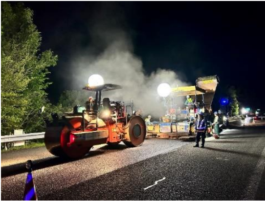
《舗装補修工事イメージ》
