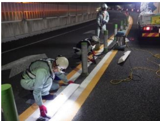
《事故復旧作業イメージ》
