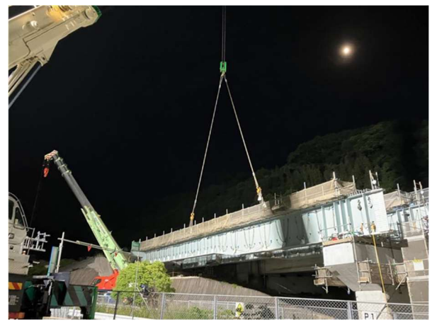
<橋梁桁架設>
