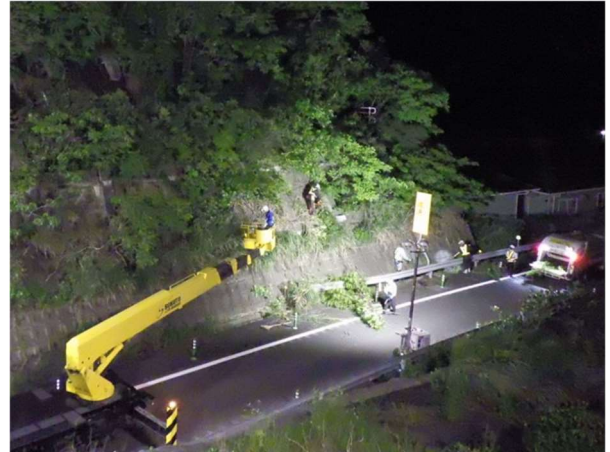
<樹木伐採作業>
