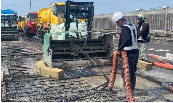
老朽化した床版の補修状況
