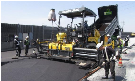
新たな舗装の施工状況
