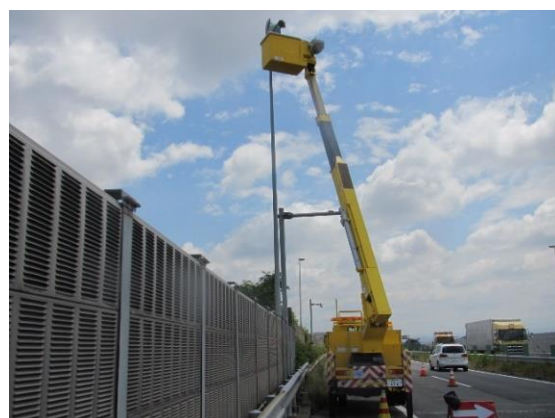
道路照明設備の点検
