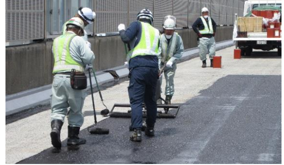
床版防水工の施工状況
