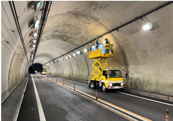
<照明設備点検>
