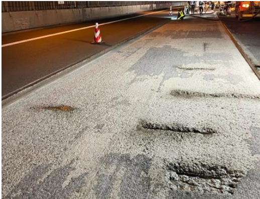
補修方法(損傷した部分の切削)
