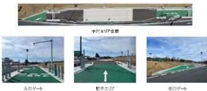
写真-8 E4 東北自動車道 那須高原 SA(上り)
