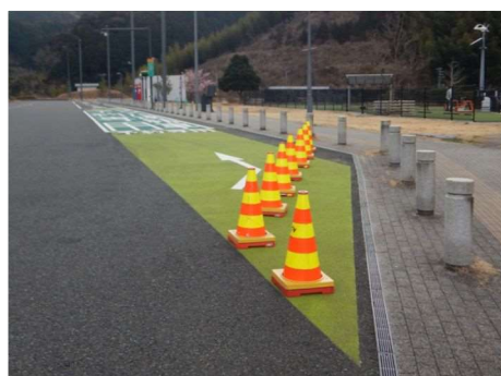
写真-13 カラー舗装による不正駐車対策 (E1A 新東名 静岡 SA(下り))
