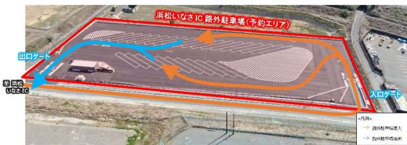
写真-6 E1A 新東名 浜松いなさIC 路外駐車場
