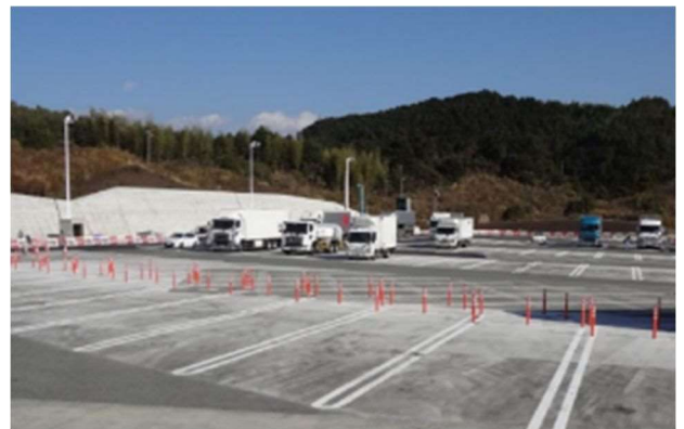
写真-4 大型車駐車場の拡幅状況
