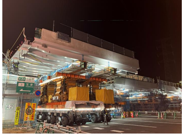
一括架設作業状況
