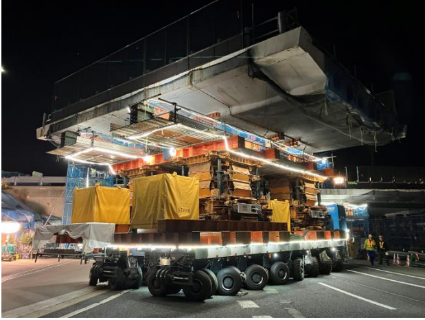
一括撤去作業状況
