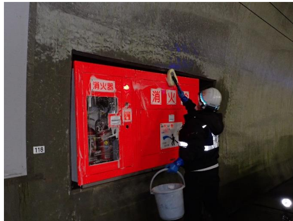
《消火栓清掃状況》
