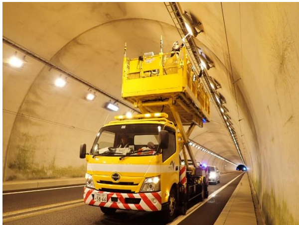
《トンネル照明設備清掃状況》
