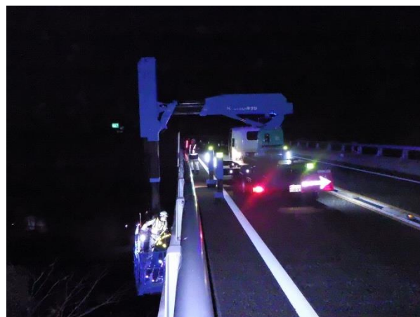
《橋梁点検状況》
