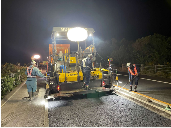
<舗装補修工事>
