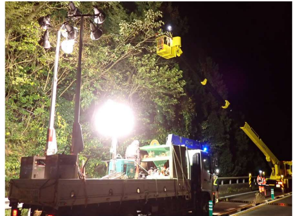
<樹木伐採作業>
