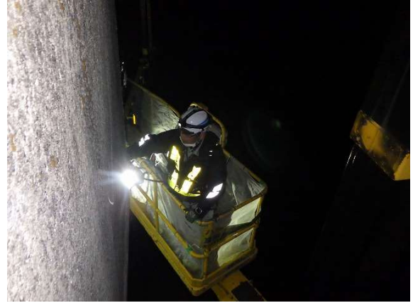
<橋梁詳細点検>
