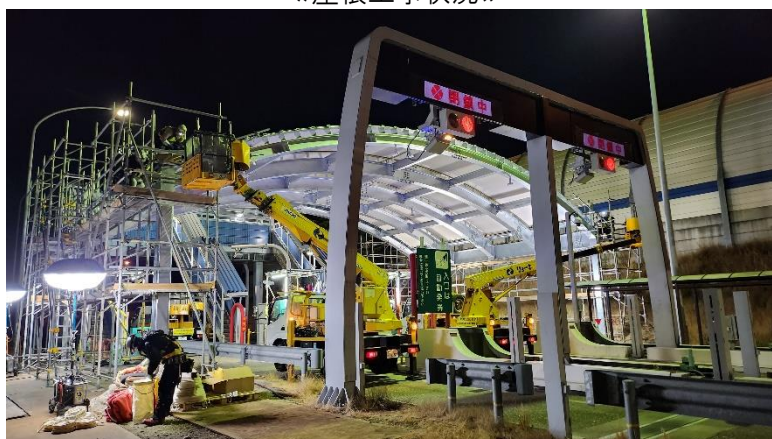
《屋根工事状況》
