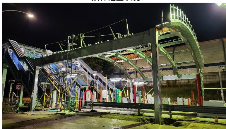
《鉄骨組立状況》
