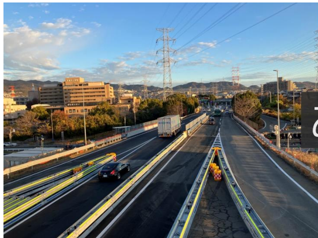
対面通行規制解除状況
