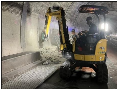
トンネル非常用設備(配水管等)撤去
