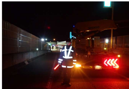
《電線路設備点検状況(イメージ)》
