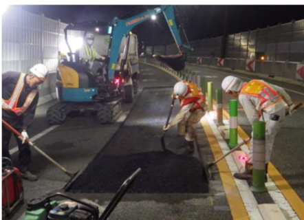
《舗装補修工事(イメージ)》
