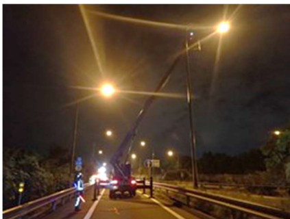
《道路照明点検状況(イメージ)》
