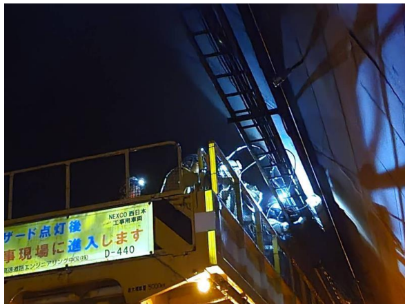
(トンネル照明設備復旧作業)
