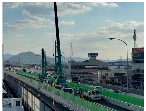
撤去状況(遠景)
