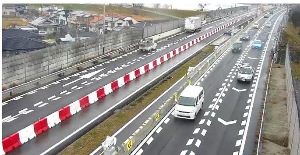
幅員減少規制の状況(遠景)
