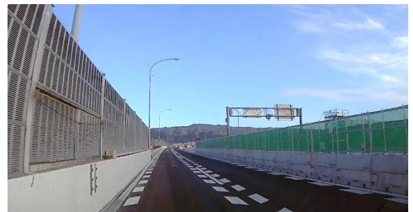
幅員減少規制の状況(通行車内)
