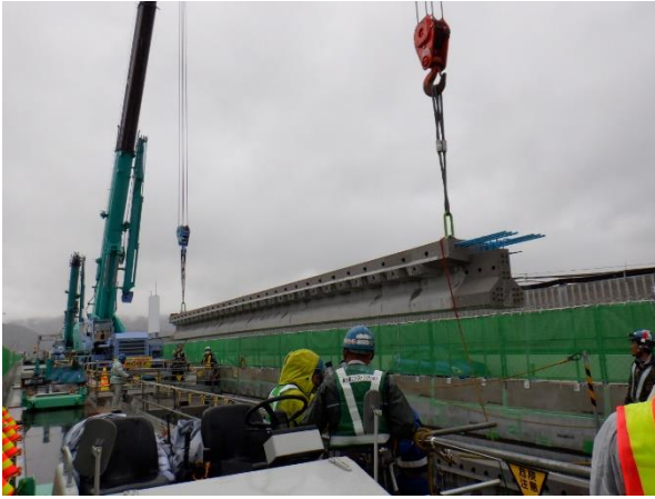
コンクリート桁の架設状況
