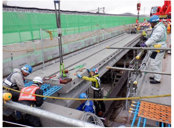
コンクリート桁の架設状況
