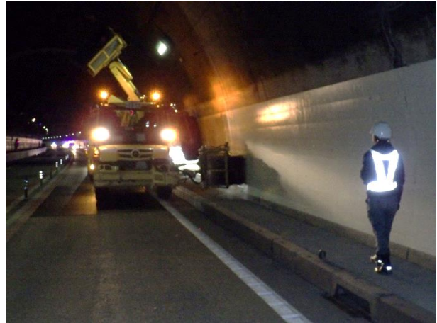
〈トンネル側壁清掃 状況〉
