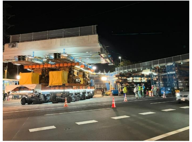
一括架設作業状況
