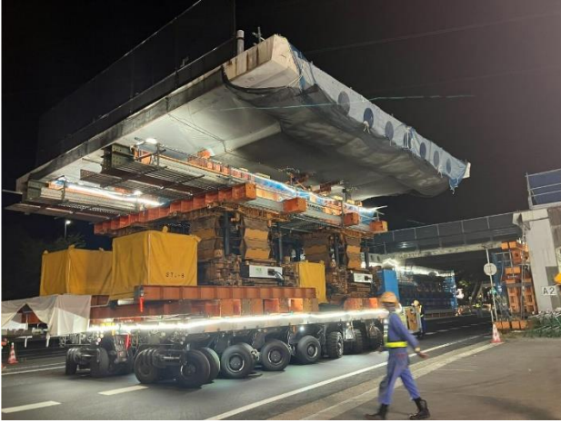
一括撤去作業状況
