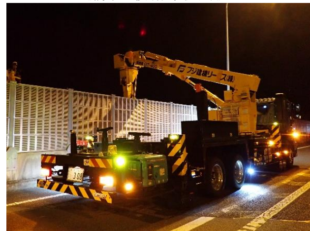
《橋梁点検(作業状況)》
