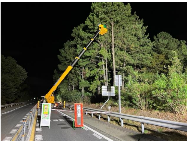
《樹木伐採(作業状況)》
