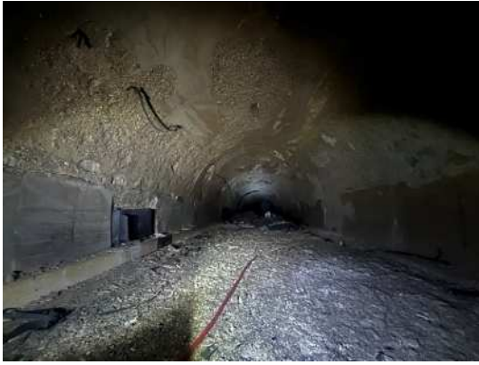
トンネル内部(全景)
