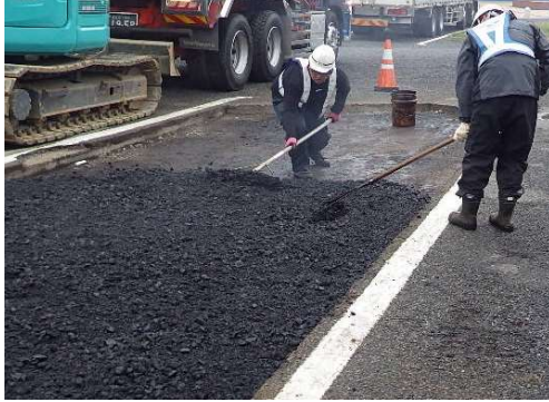
<舗装補修工>
