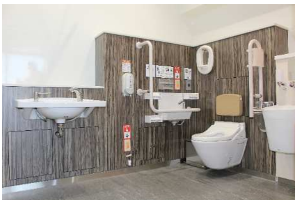
バリアフリートイレの増設(1基⇒2基)
