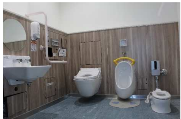
ファミリートイレの新設
