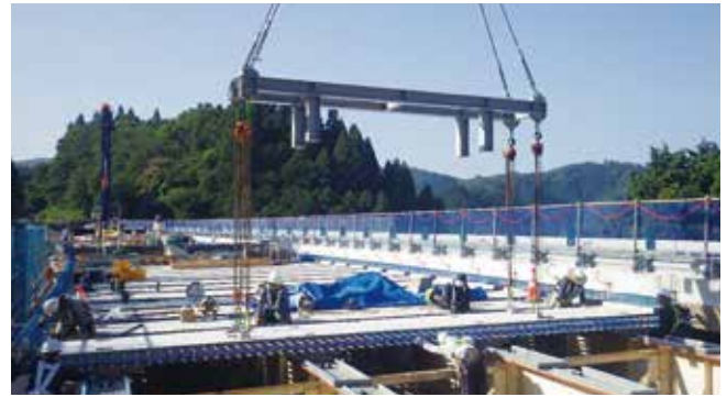
プレレストコンクリート床版架設
