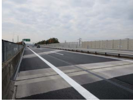
【伸縮装置取替】
