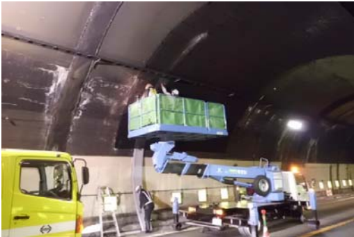
【TN漏水樋設置】
