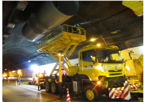
【ジェットファン撤去作業】
