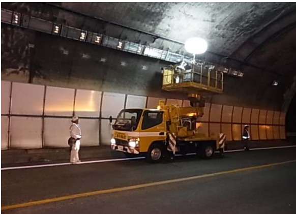
【トンネル照明設備点検】
