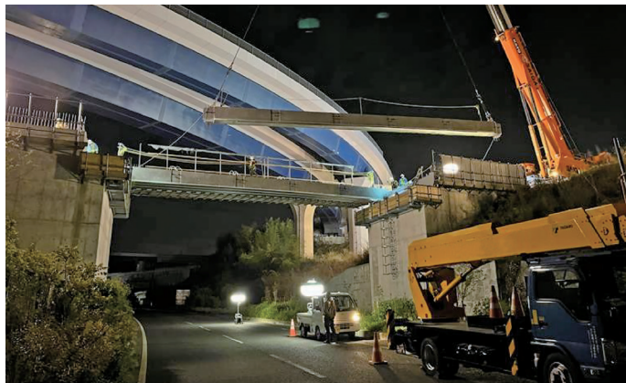
橋梁架設工事の様子(イメージ)
