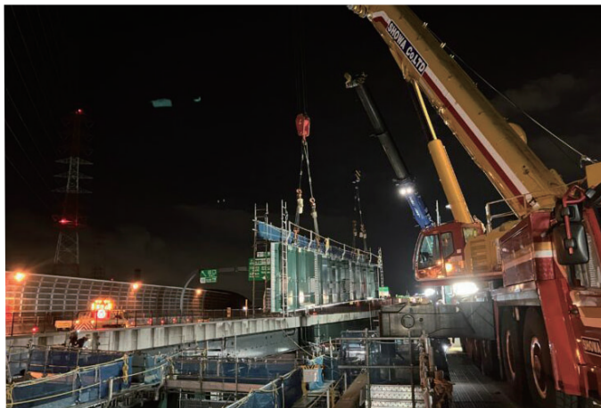
橋梁架設工事の様子
