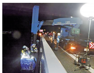
道路橋梁点検状況
