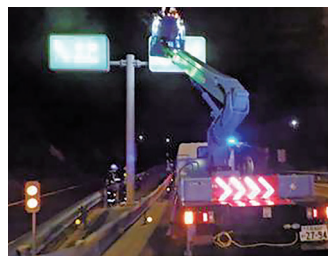
道路標識点検状況
