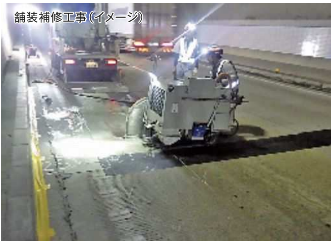
舗装補修工事(イメージ)
