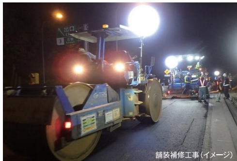
舗装補修工事(イメージ)
