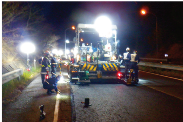
舗装補修工事(イメージ)
