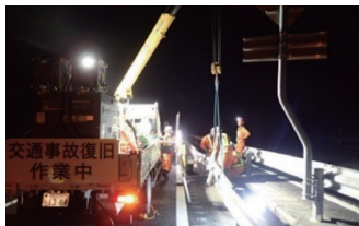
事故復旧作業
