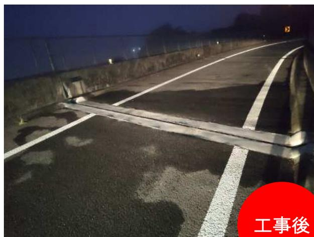
老朽化した橋梁部の伸縮装置の取替工事を実施
