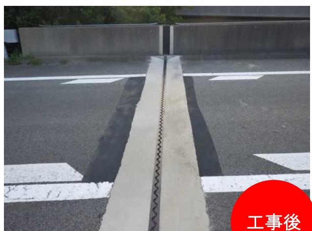
橋梁部の老朽化した伸縮装置の取替を実施
