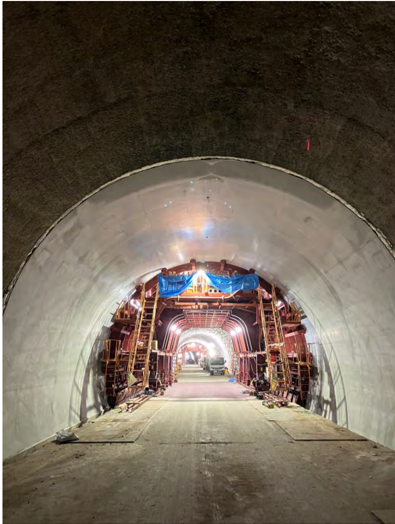
11月6日（月）コンクリート打設作業
