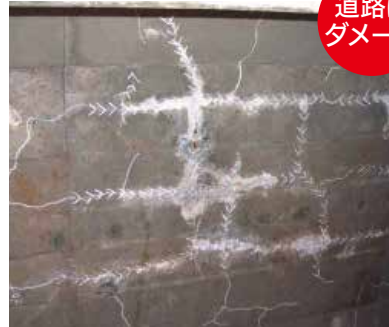
橋（床版）の損傷事例
