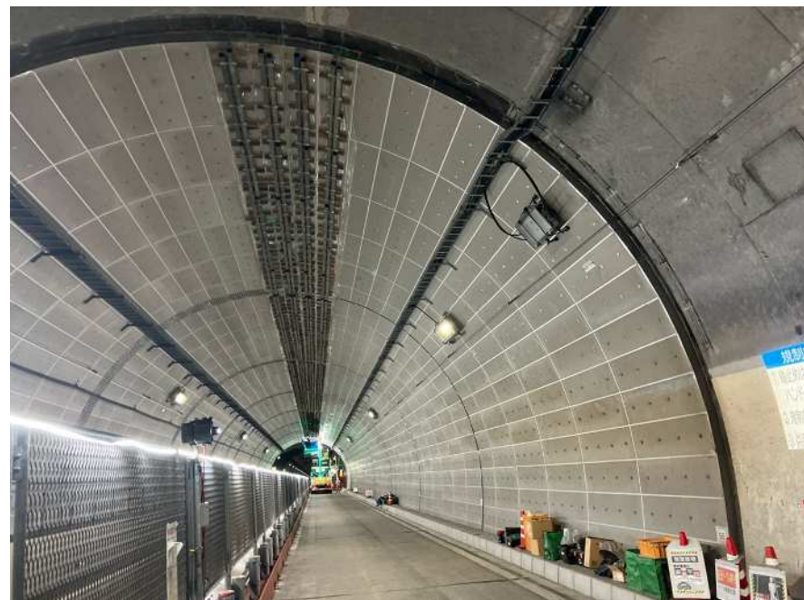
トンネル覆工内巻き工 施工状況
