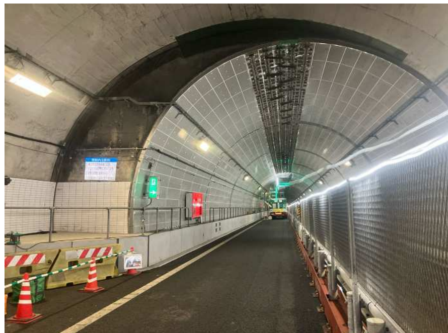
トンネル覆工内巻き工 施工状況
