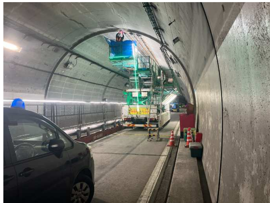
トンネル覆工内巻き工 施工状況
