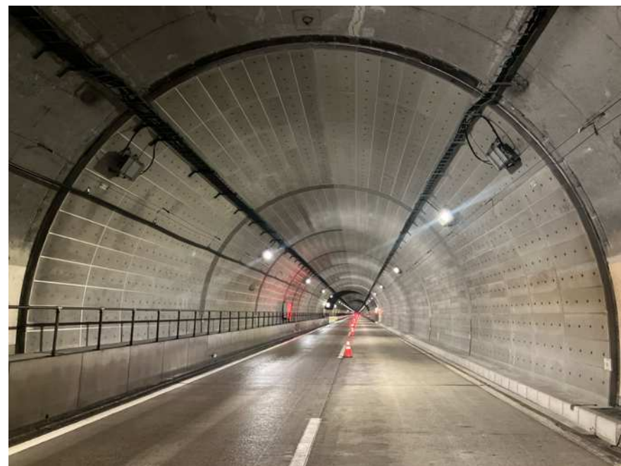
工事規制STEP⑥ 完了状況(至 松山側)
