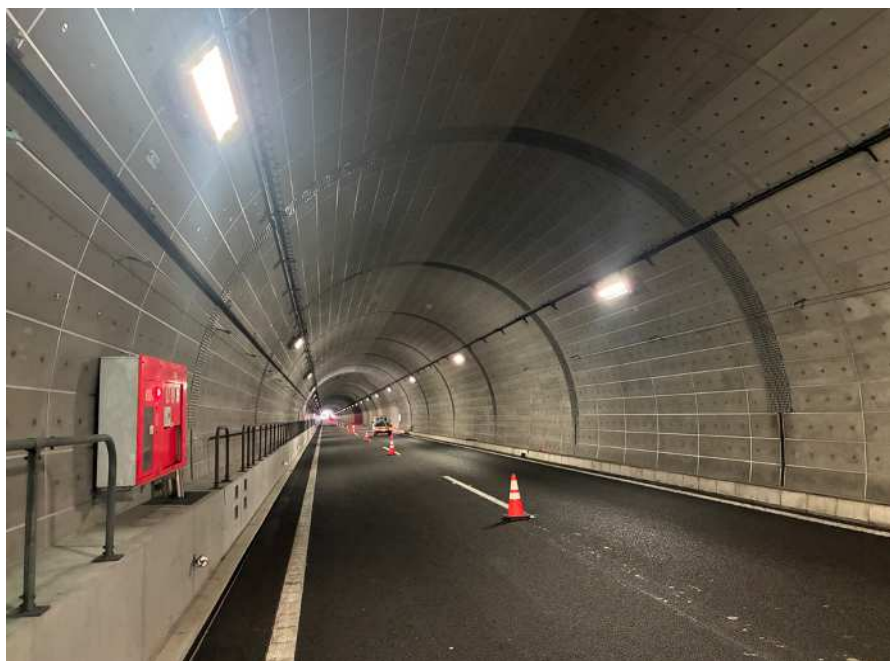
工事規制STEP⑥ 完了状況(至 川之江JCT側)
