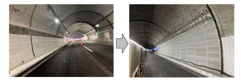
トンネル覆工内巻き工(工事規制STEP①終了時点) トンネル覆工内巻き工 完了状況(11段目)
