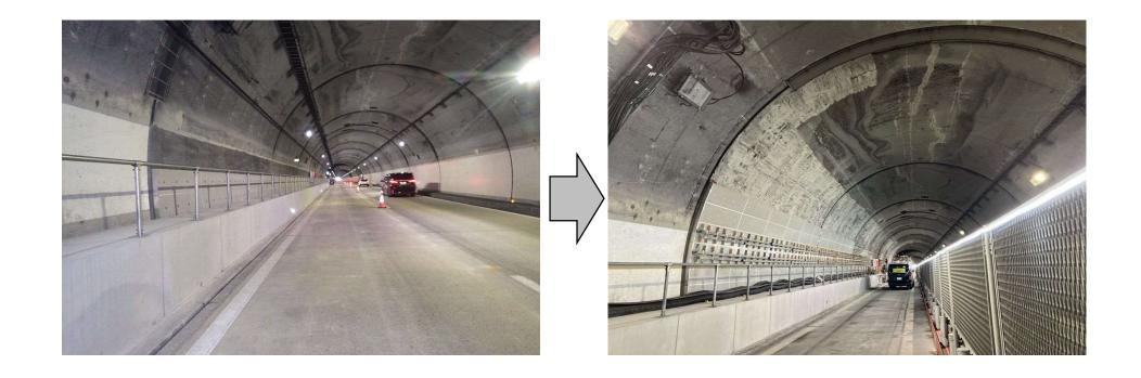
トンネル覆工内巻き工(工事規制STEP①終了時点)
