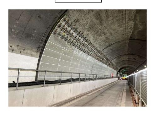
トンネル覆工内巻き工 完了状況(19段目)
