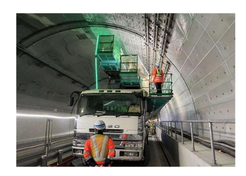
施工状況(トラック車載型システム作業床)
