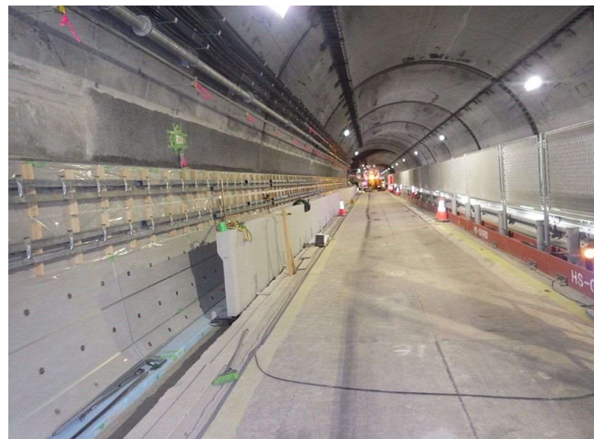
トンネル覆工内巻き工 完了状況(4・5段目養生中)
