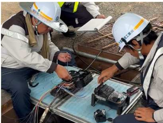
通信ケーブル接続作業
