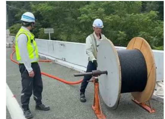
仮設ケーブル入線
