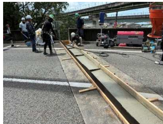
遊間部コンクリート打設
