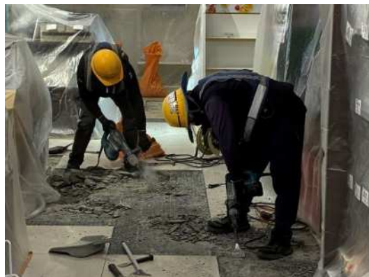
応急復旧作業
